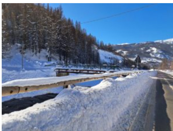
Ponte sul torrente
