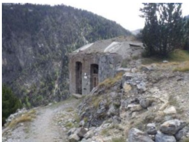
Batteria Bassa (foto tratta da Ref. 2)
