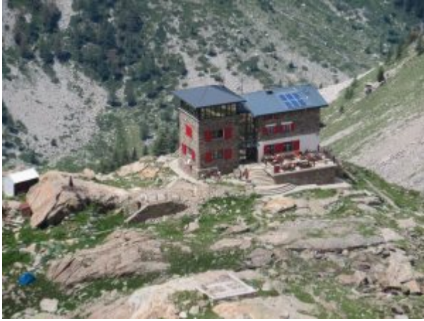
Vista sul Rifugio Remondino
