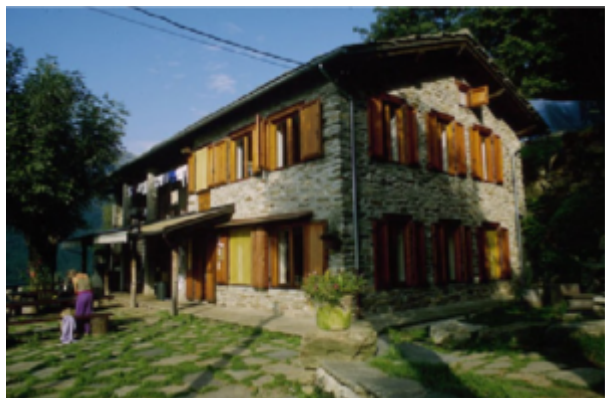
Rifugio Bruno Piazza (immagine presa da sito)
