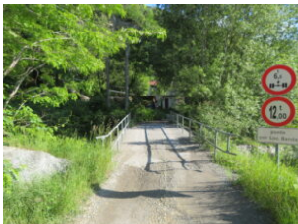
Ponte per Località Banda
