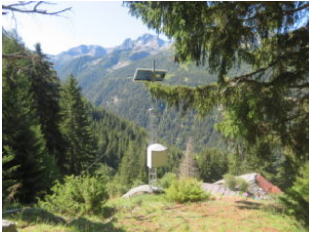
Stazione di segnalazione di movimenti franosi
