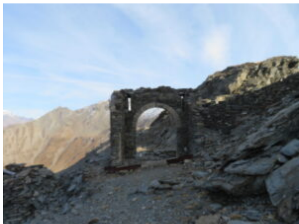
Da lì per la via dell'andata.
