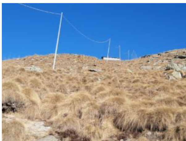
In vista del rifugio
