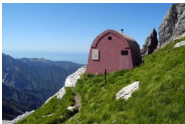
Bivacco Aronte. Immagine tratta dal sito https://www.cailiguregenova.it/pag/rifugio-aro
