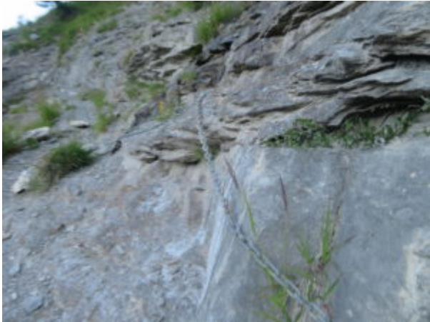
Catene in un tratto franoso
