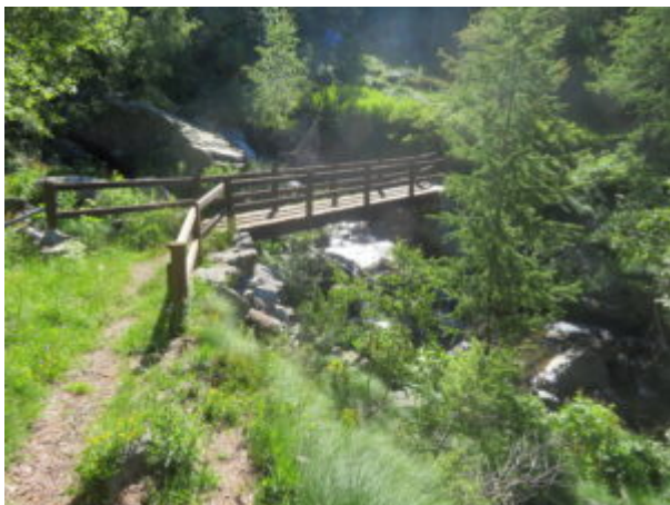
Ponte in legno
