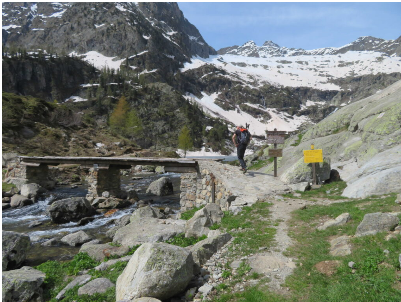
Ponte sul Rio Meris
