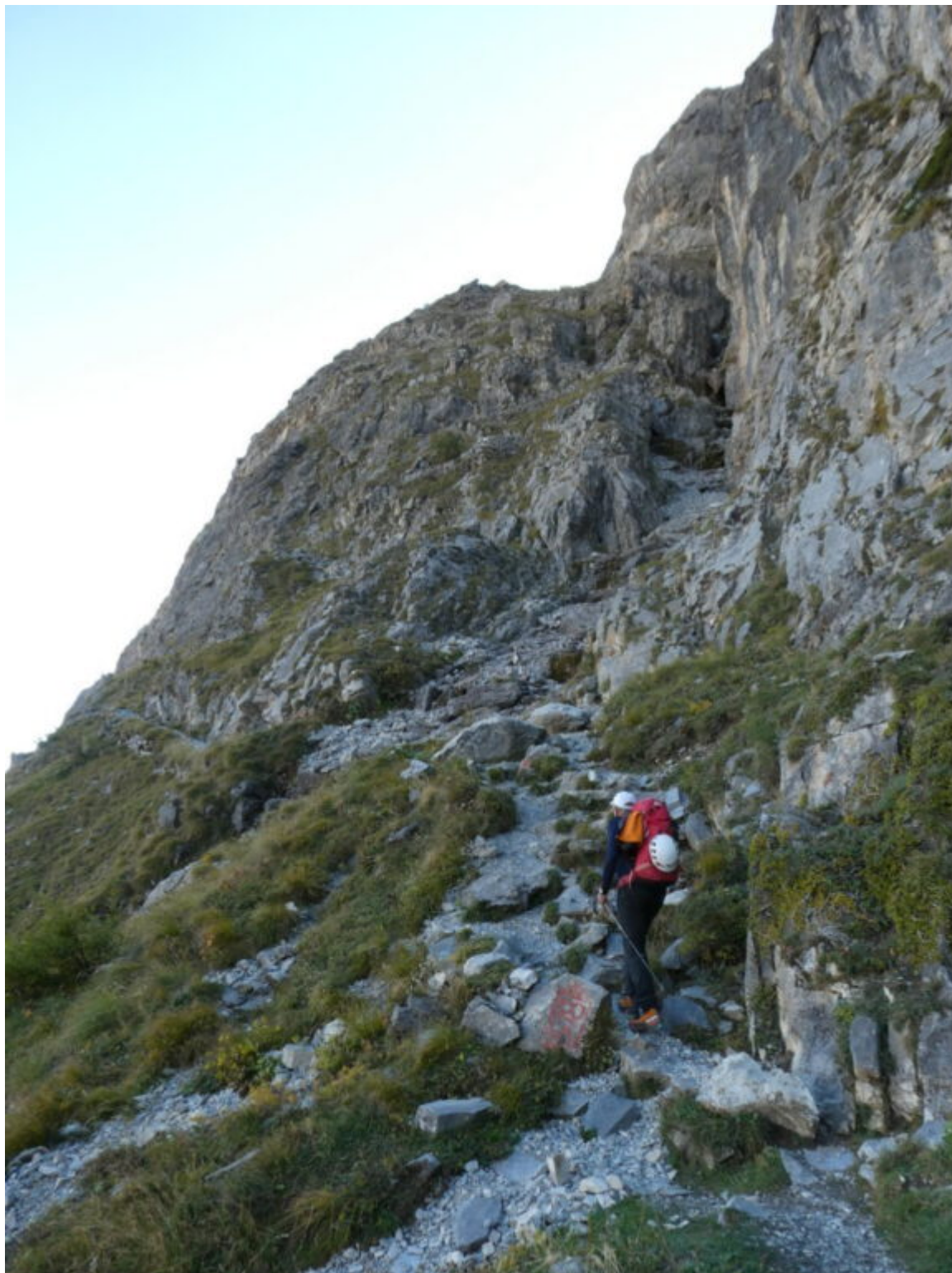
Il sentiero fu costruito dal Battaglione Alpini Valcamonica nel lontano 1940.
